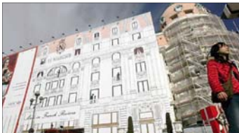
Au Négresco, la banque HSBC a financé la totalité de la bâche et une petite partie des travaux de ravalement. (Photo Franck Fernandes)
